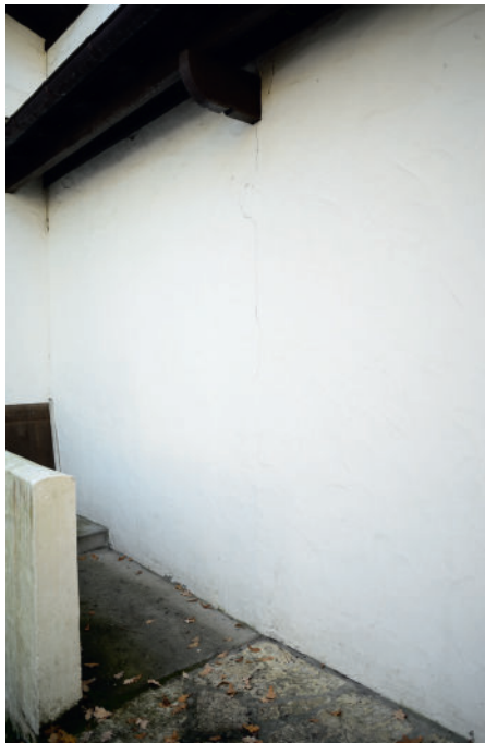
Une fissure plus ou moins visible selon l'angle de prise de vue.
